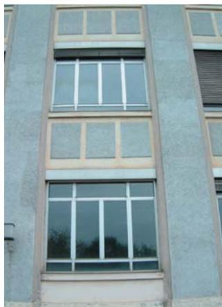
Détail de la façade sud : une des 19 travées de 4,75 m de large aux verticales accusées. Les fenêtres en bois ont été remplacées en 1966 par des modèles en aluminium (SMS).
