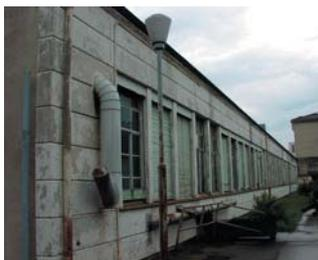
*La façade sud avec son bardage de panneaux préfabriqués en ciment (SMS).*
