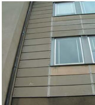
*Gros plan sur le bardage en panneaux de ciment préfabriqués (SMS).*
