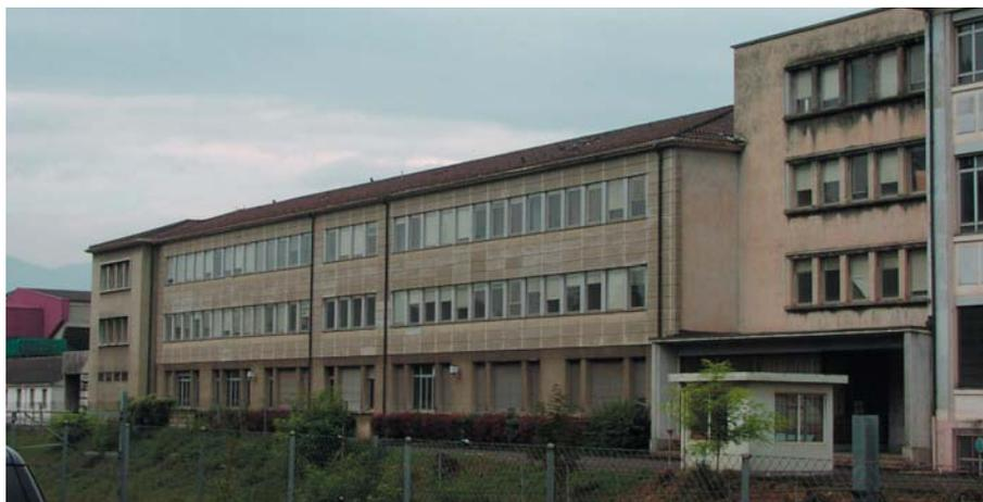
*Bâtiment des services techniques, élévation sud (SMS). Un édifice mixte réalisé avec une grande économie de moyens, le béton et l'acier étant rationnés.*
