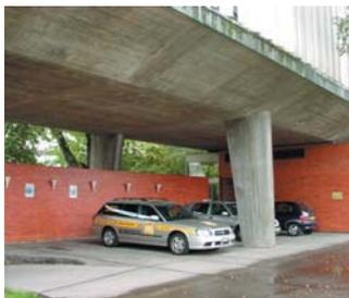
Vue de la dalle profilée à la hauteur de la coupe transversale. Les places de stationnement de la direction sont éclairées par des appliques fixées sur un mur d'arrêt en briques (SMS).
