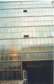
La structure en acier de la verrière est constituée de modules de 1 m sur 0,5 m (SMS).
