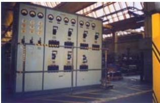
Tableau de commande électrique d'origine. La « lumière » est séparée de la « force » (SMS).
