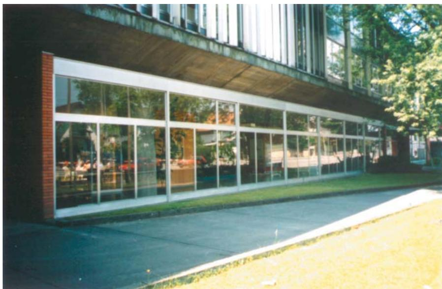
Aménagés en retrait de la dalle, les panneaux du rez-de-chaussée n'ont pas de rôle statique (SMS).
