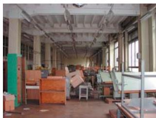
Travée sud du rez-de-chaussée. On distingue les nervures de la dalle du 1er étage (SMS).
