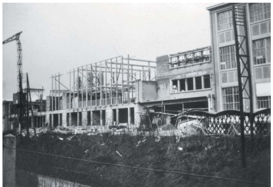
1943, construction du bâtiment des services techniques dans le prolongement du bâtiment Pic-Pic. Aux étages, l'ossature en béton est revêtue d'un bardage en ciment.
