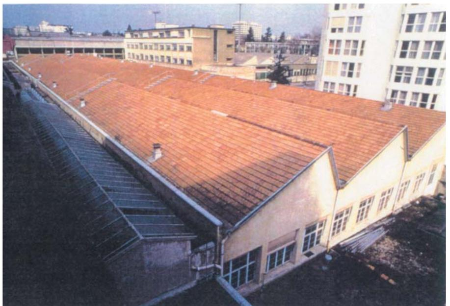
*Appelé «shed fabrication», le vaste atelier de fabrication avec ses trois travées recouvertes d'une toiture à redents orientée vers le nord (IE).*
