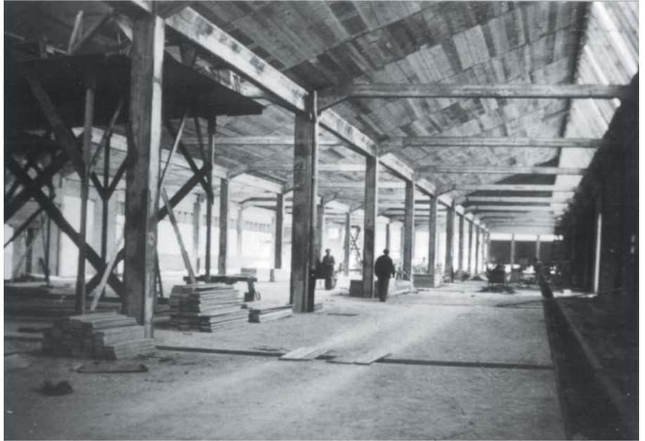
1943-1944, vu depuis l'est, le «shed fabrication» en voie d'achèvement. Les sous-poutres sont en béton précontraint, un procédé mis au point une dizaine d'années auparavant.
